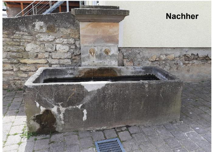
Die Kammer - Übeltäter der Undichtigkeit - wurde geschlossen. Es gibt nun eine direkte Verbindung vom Zulauf zum Auslauf, diese Leitung wurde neu hinter dem Brunnenkörper verlegt. Auch wurden die Ausläufe und deren Rosetten erneuert.
